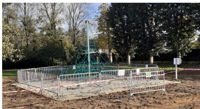
(Fin des travaux, engazonnement de l'espace décembre 2023)
