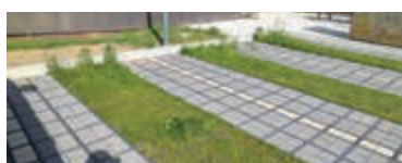
Stationnements végétalisés avec infiltration gravitaire du ruissellement
